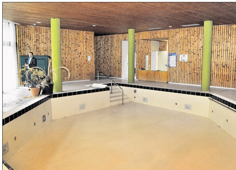
LEERSTAND SEIT LANGER ZEIT: Das Hallenbad im Helmut-Dahringer-Haus wird schon seit Jahren nicht mehr genutzt. Foto: Mandic
